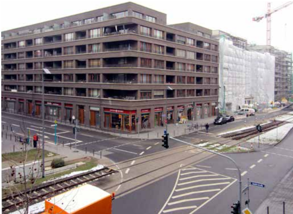
Ansicht der Eckbebauung mit Loggien nach Westen und Süden
