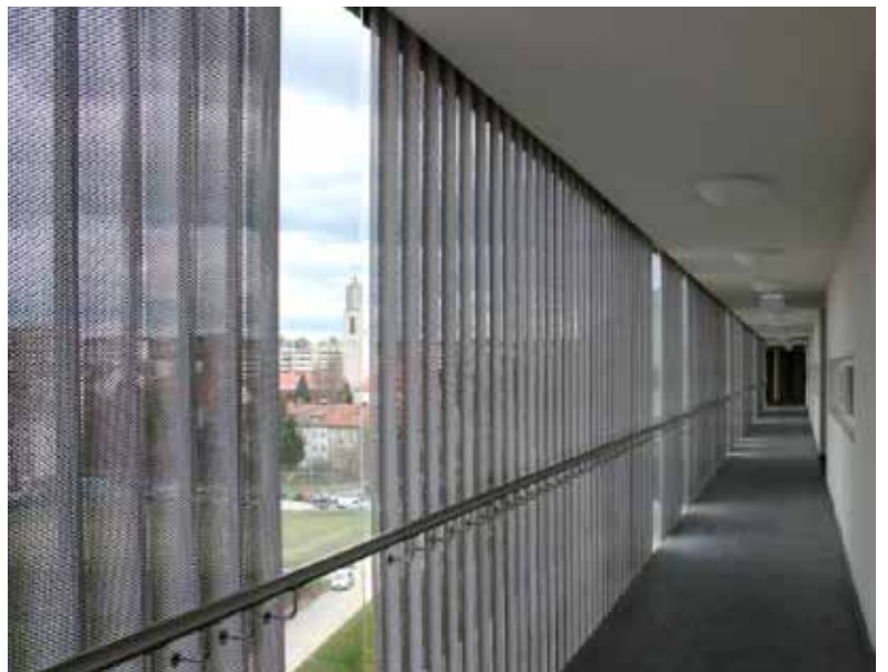
Erschließungsgang (Laubengang) Seniorenwohnungen Foto: Paul Ott
