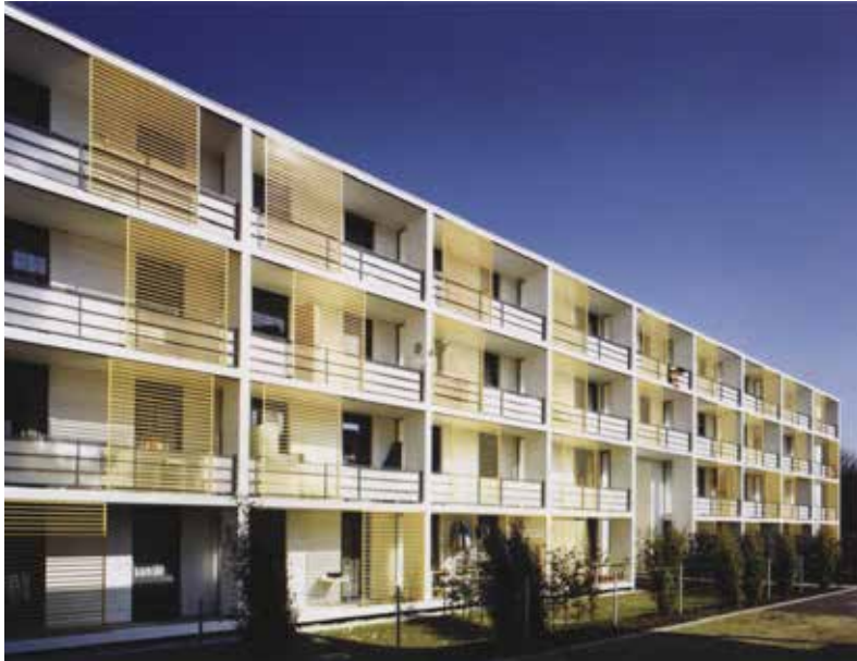
Fassade mit verschiebbarem Sonnen- und Sichtschutz
