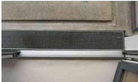
Zugang Loggia (Aufsicht)
