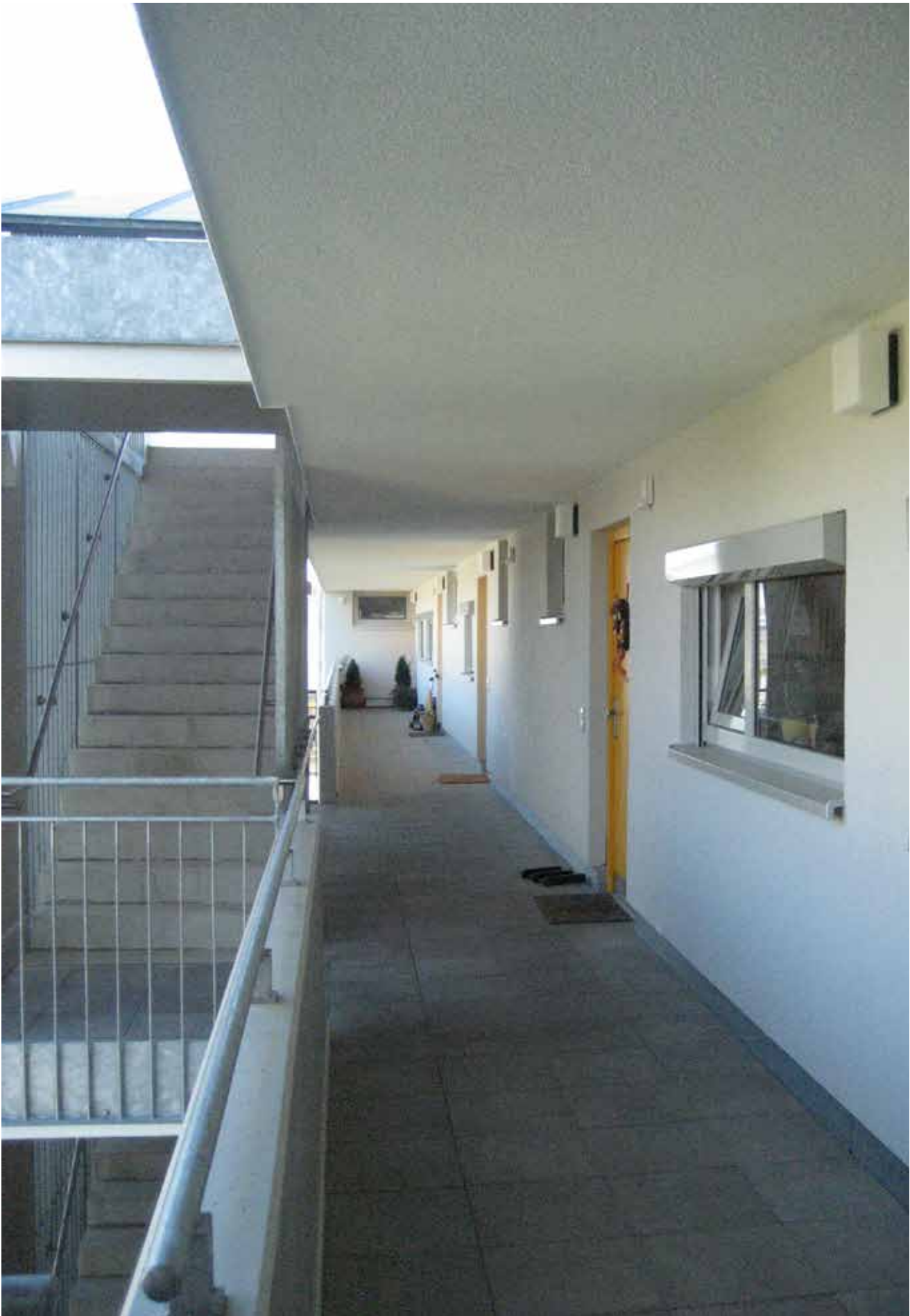
Außengang mit breiter notwendiger Treppe und beidseitigen Händläufen
