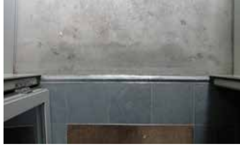
Hauseingang mit Halbrundschwelle (Aufsicht) Foto: EM
