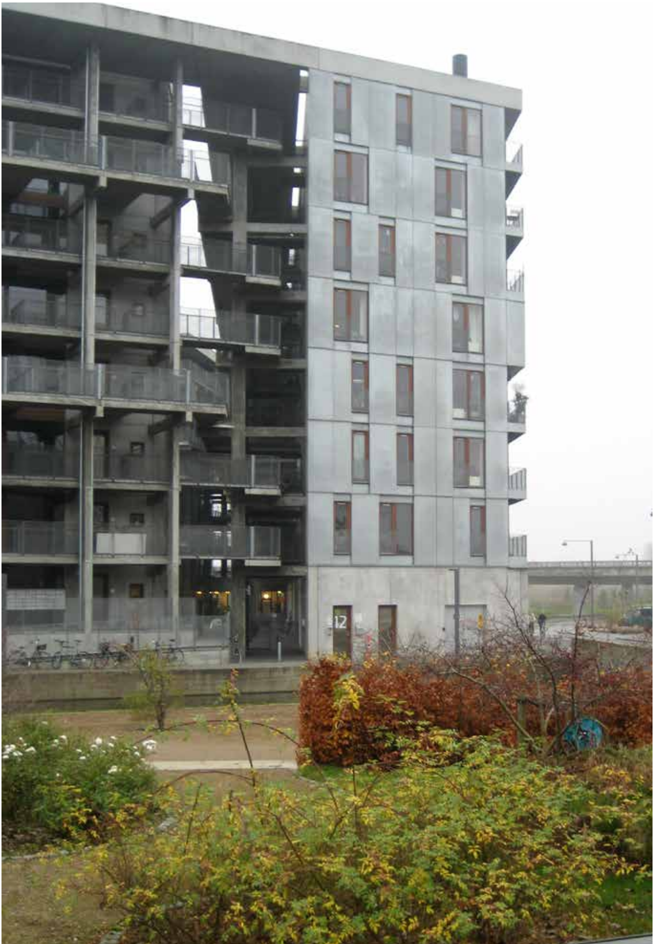
Loggia als Wohnraumerweiterung mit beidseitiger Isolierverglasung
