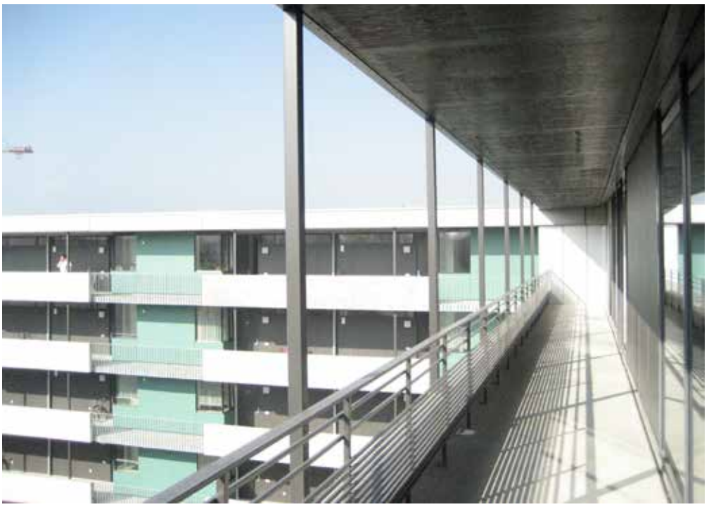
Außengängerschließung von der Dachterrasse des Gemeinschaftsraumes aus gesehen
