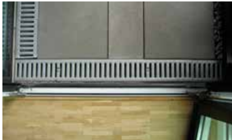
Zugang auf die Loggia (Aufsicht)
