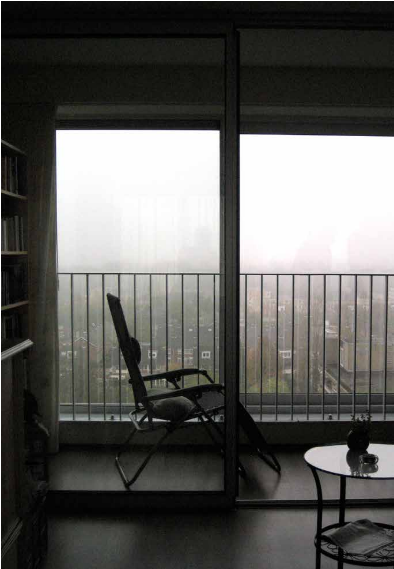
Loggia als Wohnraumerweiterung mit beidseitiger Isolierverglasung
