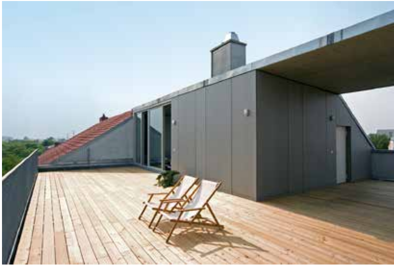
Dachterrasse mit Gästewohnung
