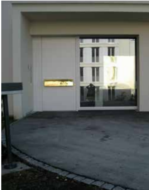
Hauseingang mit geneigter Zuwegung Foto: EM
