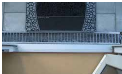
Zugang Dachwohnung (Aufsicht)
