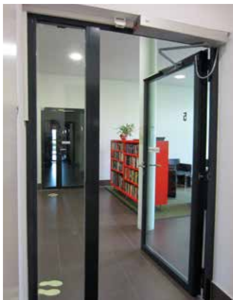
Treppenzugänge für die Häuser 3 und 5 Foto: EM
