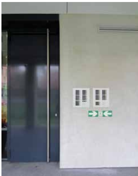
Hauseingangstür mit zus. Schlüsselschalter Foto: EM
