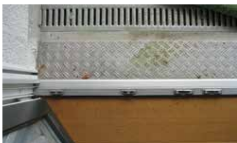
Zugang Loggia (Aufsicht)
