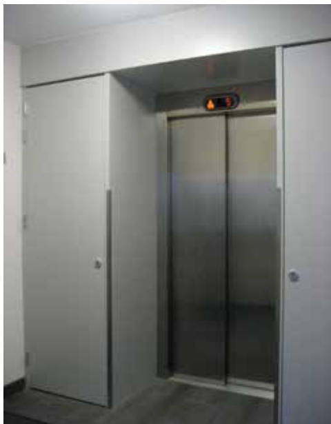
Zugang zu den privaten Stauschränken Foto: EM
